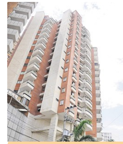
SIERRA IMPERIAL - Apartamentos. - Metros cuadrados: 10.305. - Altura de la edificación: 18 pisos. - Unidades de vivienda: 56.
