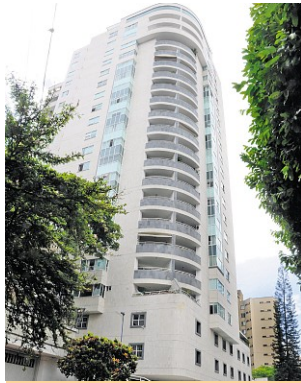
SIERRA DEL LLANO - Apartamentos. - Metros cuadrados: 15.614. - Altura de la edificación: 21 pisos. - Unidades de vivienda: 66.
